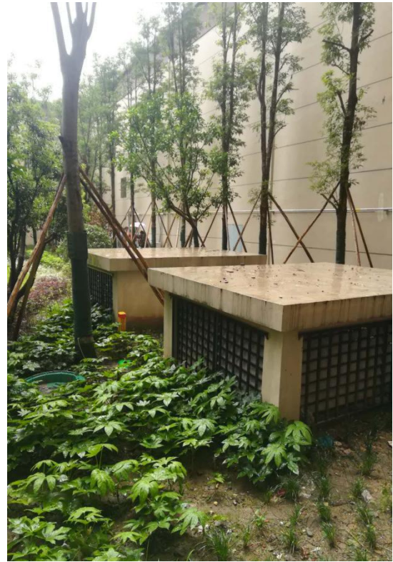
车库汽车尾气排放口
