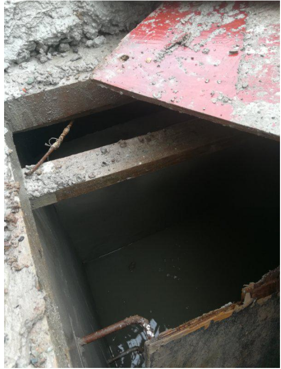
污水处理隔油池与污水管网结合情况
