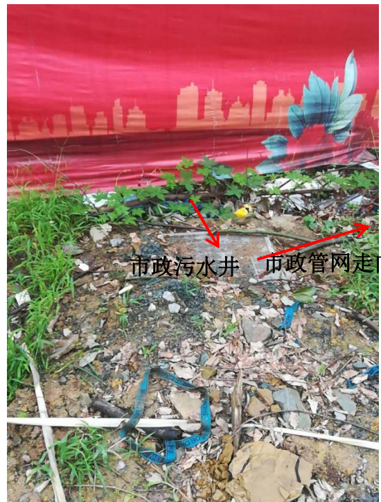
污水处理生化池与市政管网结合情况
